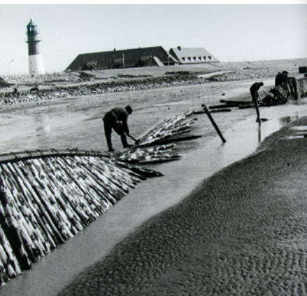
Deichbau in Büsum, 1962 Heute betreut der Landesbetrieb für Küstenschutz, Nationalpark und Meeresschutz SH (LKN.SH) die Außendeiche.
