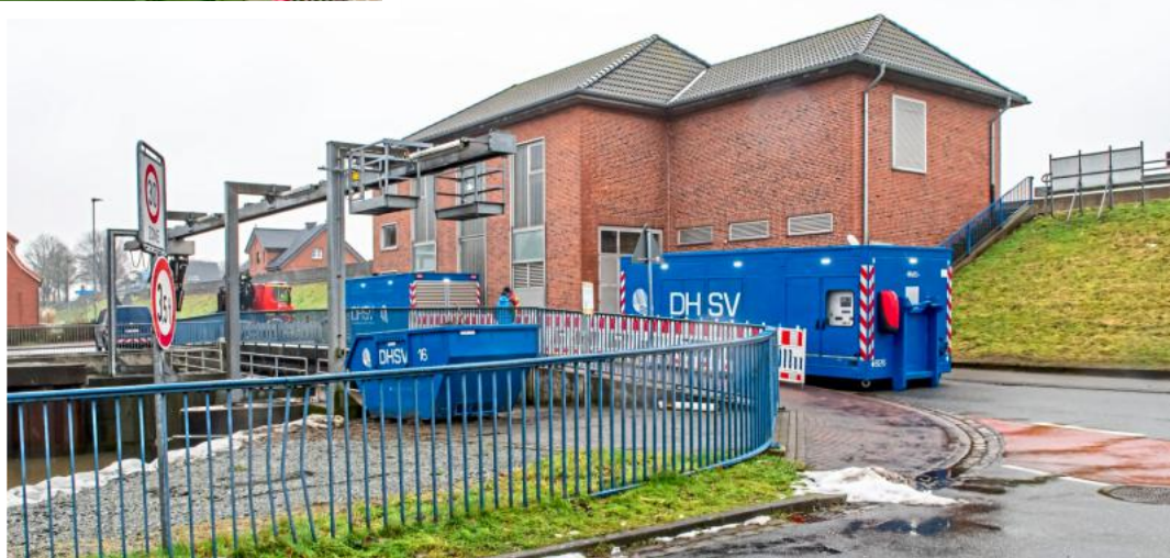
Die beiden Notstromaggregate versorgen die drei Pumpen des Schöpfwerkes, die jeweils sechs Kubikmeter Wasser in der Sekunde fördern und somit für die Entwässerung von knapp 10000 Hektar Hinterland bis nach St. Michaelisdonn sorgen. Foto: Turchetto
